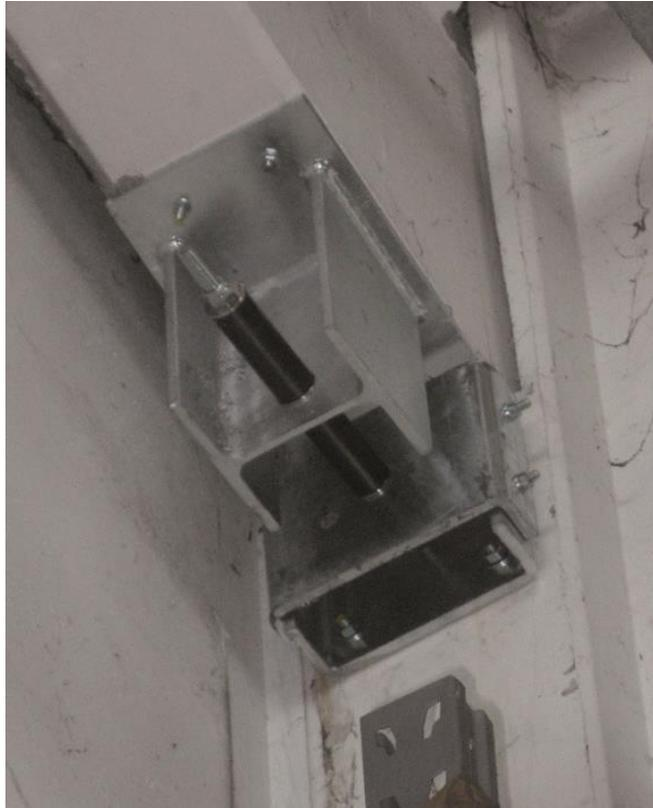
Collegamenti dissipativi tra elementi prefabbricati in c.a. mediante l'introduzione di dispositivi antisismici di vincolo a fusibile dissipativo
