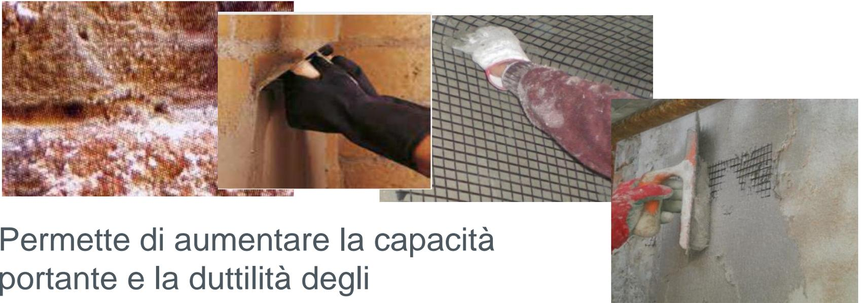
Permette di aumentare la capacità portante e la duttilità degli elementi rinforzati mediante l'applicazione di rete di armatura in vetro o basalto con rasatura di malta fibrorinforzata.
